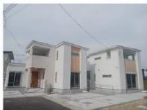
4号棟・5号棟 外観
